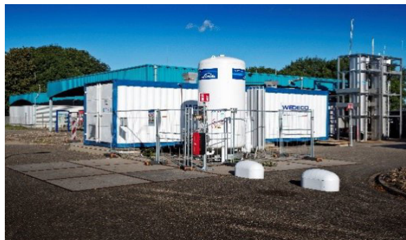
Met het project S.C.H.O.O.N. onderzoekt het hoogheemraadschap hoe het gezuiverde water extra kan worden gezuiverd om het vervolgens in het gebied te kunnen terugbrengen, in plaats van het te lozen in zee of in de Nieuwe Waterweg. Met de proefinstallatie “de zoetwaterfabriek” op De Groote Lucht in Vlaardingen zijn de extra zuiveringsstappen onderzocht. 25
